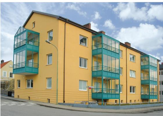
Le système avec cadre permet l'utilisation de remplissages jusqu'à 18 mm d'épaisseur. L'installation de verre feuilleté avec serrure brevetée permet une protection supplémentaire contre le cambriolage, et la possibilité d'utiliser du verre double vitrage améliore grandement le confort thermique. L'utilisation de joints à brosse de haute qualité fournit une bonne barrière acoustique pour le balcon.
